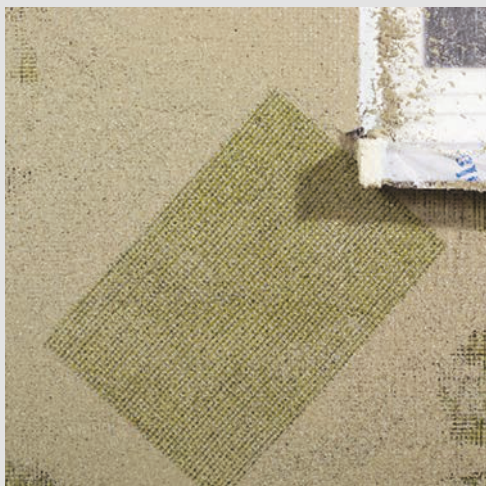
Армирование на углах оконного проема
