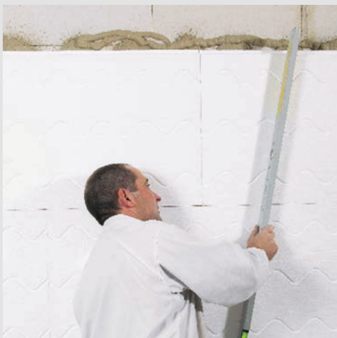
Выравнивание поверхности плит утепления
