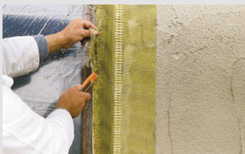
Установка углового профиля
