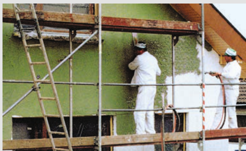
Нанесение раствора КНАУФ-Севенер
