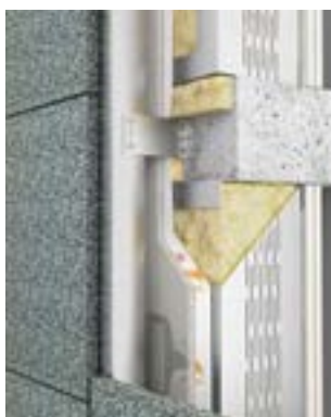
Одноконтурная конструкция стены с защитной облицовкой
