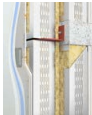
Двухконтурная конструкция стены
