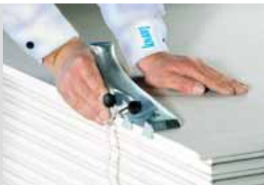
Обрезанные кромки строгаются под углом для формирования качественного шва
