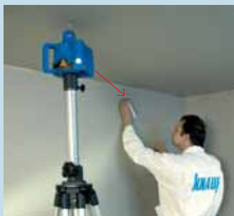
Разметка на больших строительных объектах быстро производится с помощью лазерной установки.
