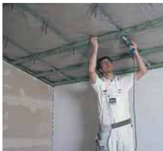
Установка основных профилей каркаса
