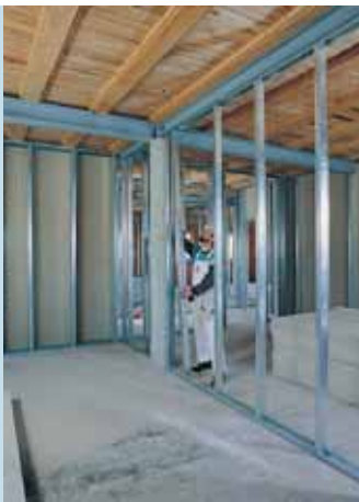
Установка металлического каркаса
