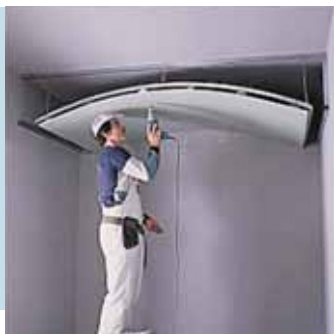
Установка и закрепление изогнутых листов обшивки
