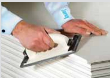
Возможные заусенцы на картоне следует удалить
