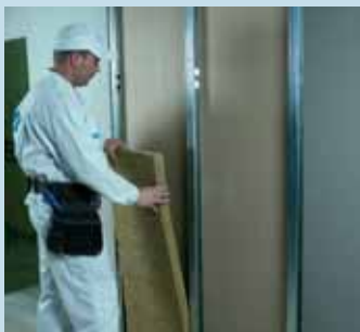
Укладка изолирующего материала
