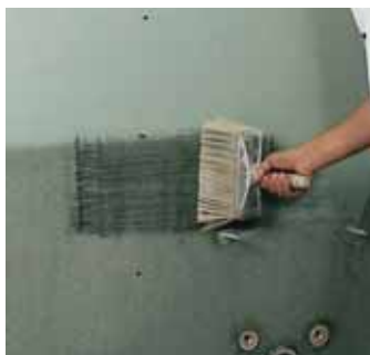
Грунтование с применением КНАУФ-Тифенгрунд производится щеткой
