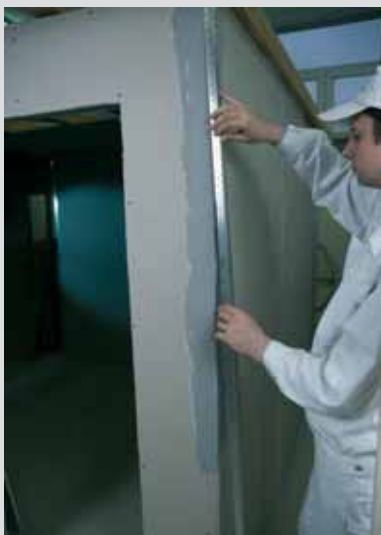
Установка профиля для защиты углов путём утапливания в слой шпаклёвки
