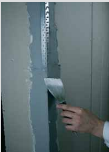
Шпаклевание внешнего угла
