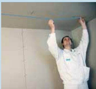
Разметка подвесного потолка
