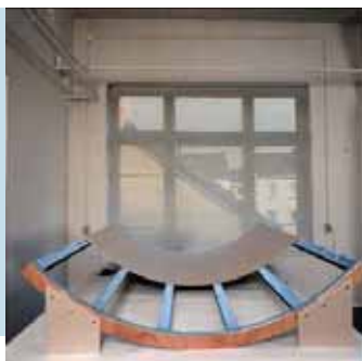
Изготовление элемента обшивки для криволинейной перегородки
