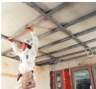
Установка несущих профилей каркаса
