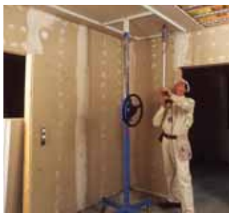
Установка КНАУФ-листов на готовом каркасе
